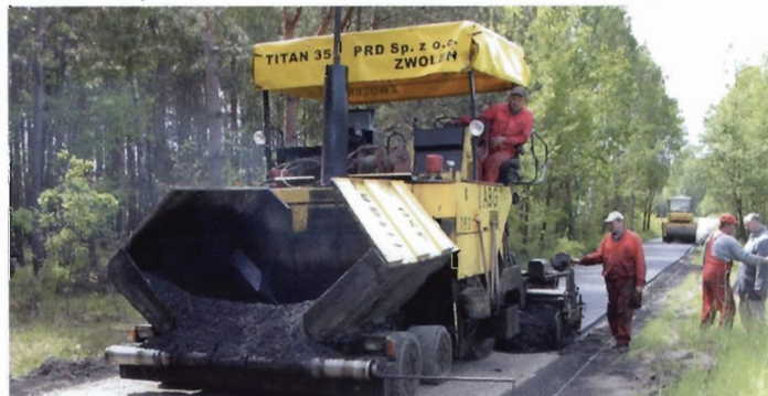
Droga Gminna realizowana z Unijnych środków - Wójt Gminy Bogdan Czapla na miejscu budowy drogi
