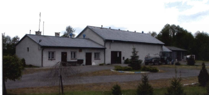
Gminna Oczyszczalnia Ścieków
